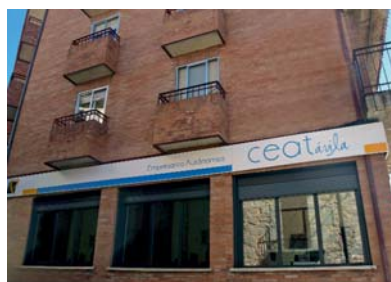
A la izq. fachada exterior sede CEAT ÁVILA Piedrahita
